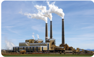
Termocentrali nga i cili fitohet energjia elektrike
