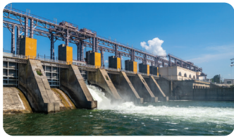
Hidrocentrali nga i cili fitohet energjia elektrike
