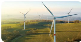
Turbinat me erë për prodhimin e energjisë elektrike.
