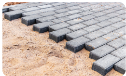
Përdorimi i rërës si bazament në shtrimin e kubëzave
